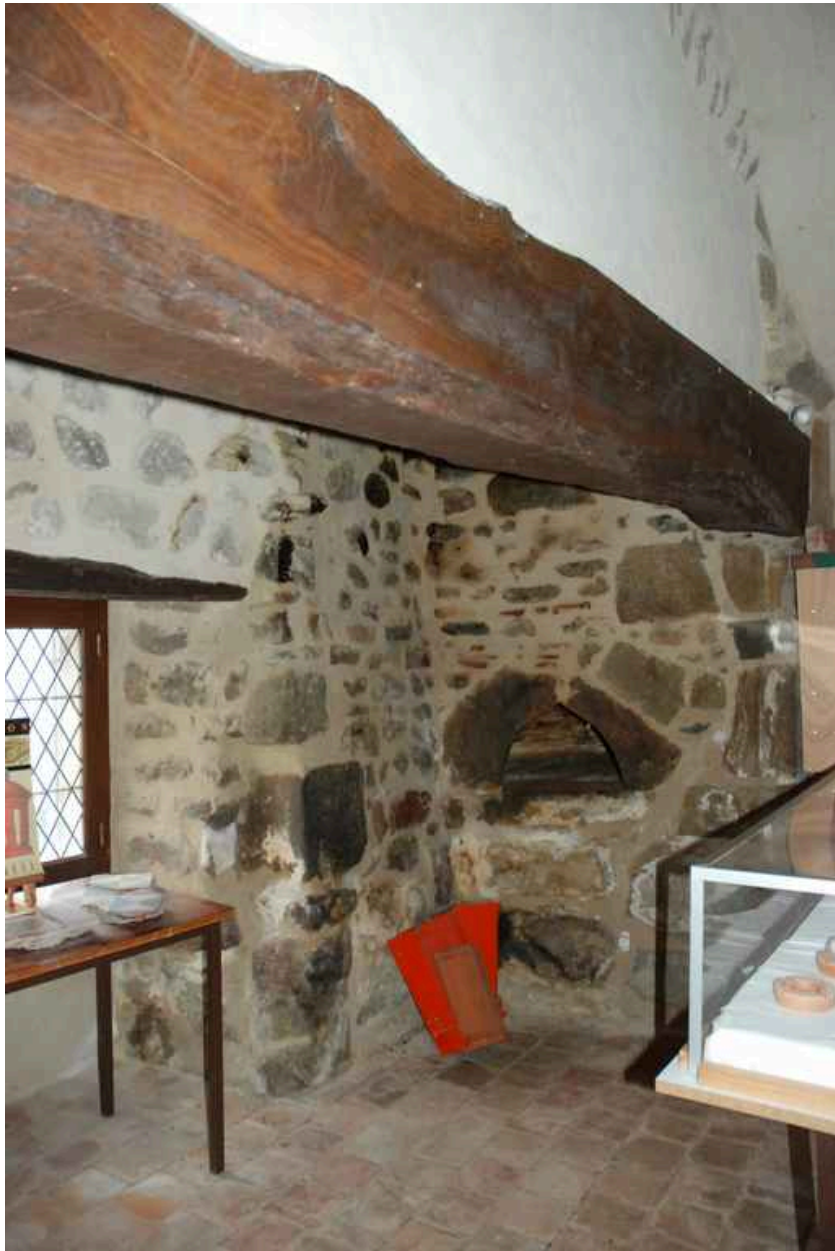
Aile ouest, vue intérieure de la 'cuisine' : cheminée avec four à pain, contre le mur nord.
