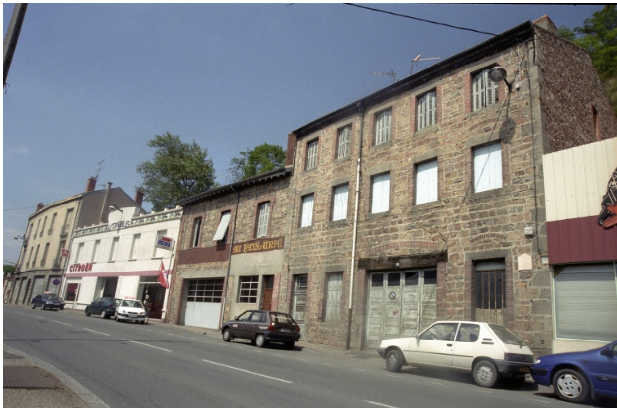
Boën, îlot 17, Lyon (rue de) 79 et 77. Vue générale de la façade sur rue.
