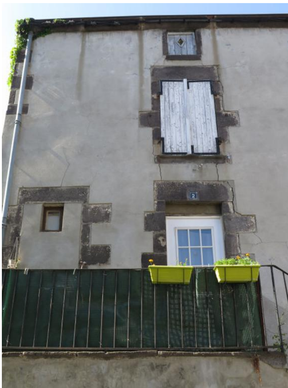
Vue partielle de la façade principale
