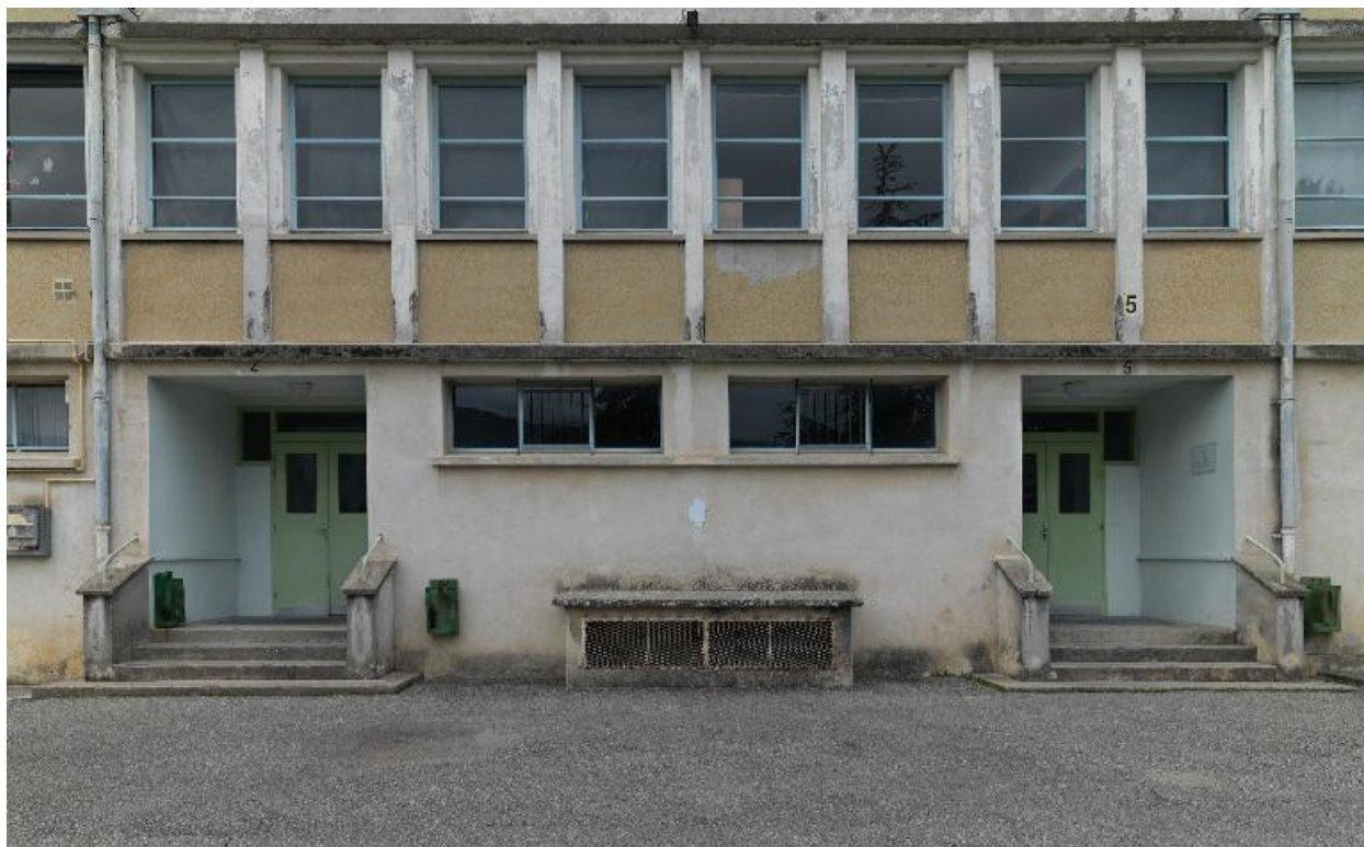
Bâtiment de l'internat : entrée centrale
