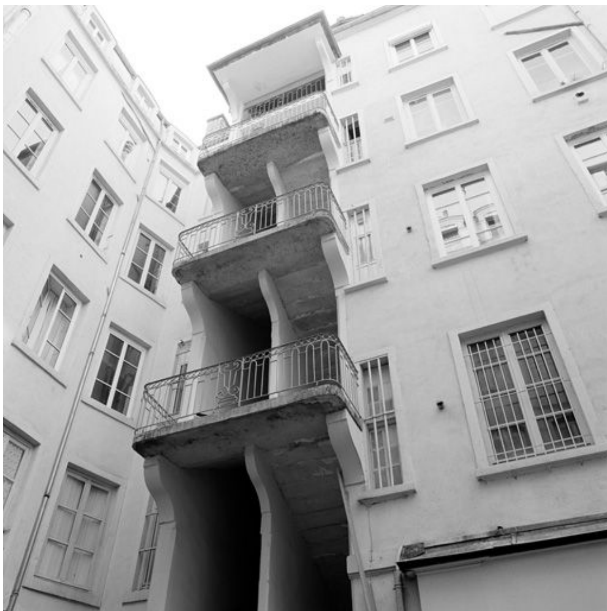
2e cour, partie supérieure de l'escalier
