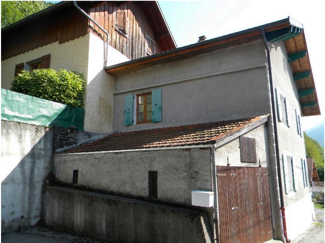
Façade nord d'une maison remaniée (2008 D14 2157).
