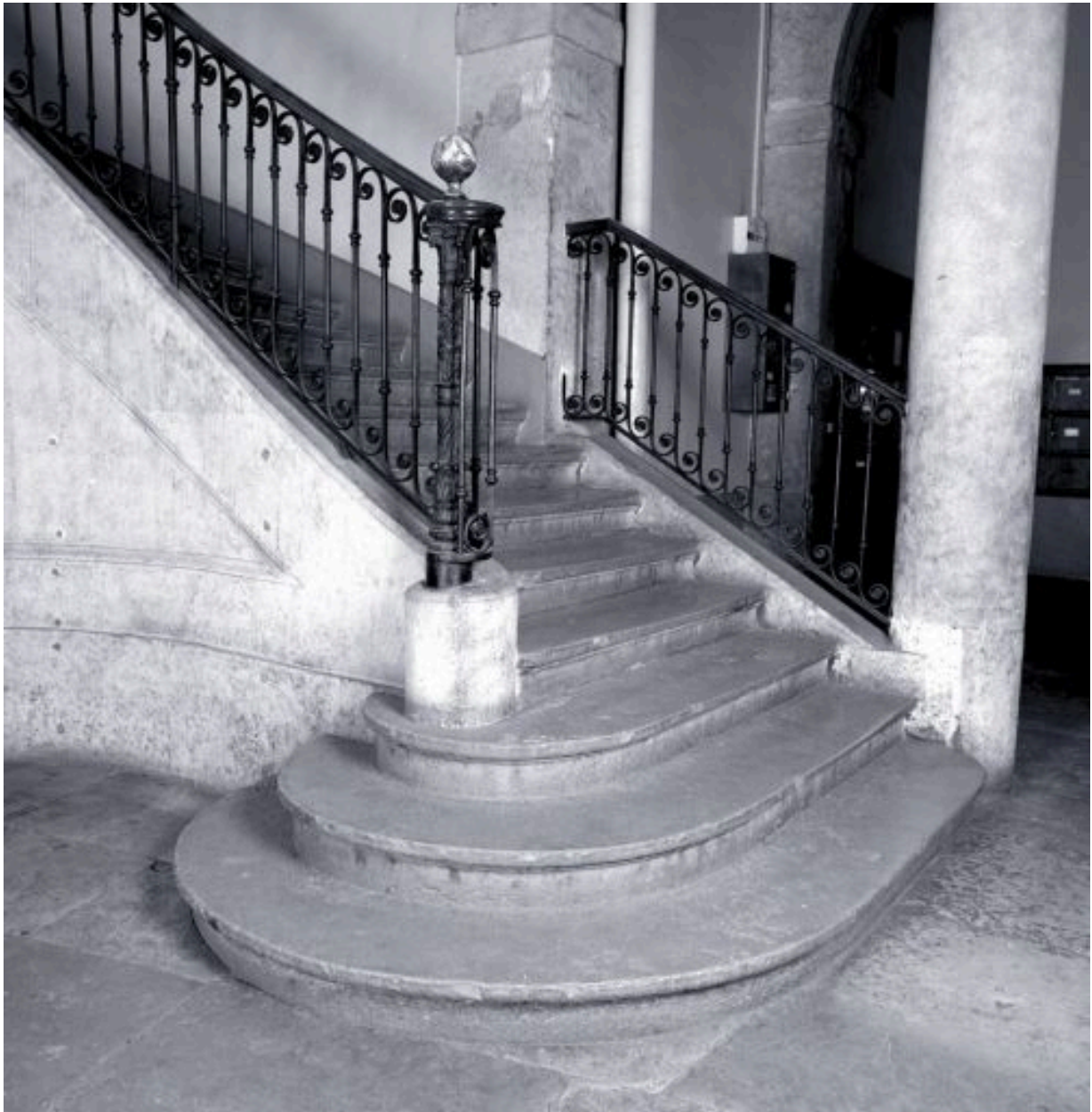
Le départ de l'escalier
