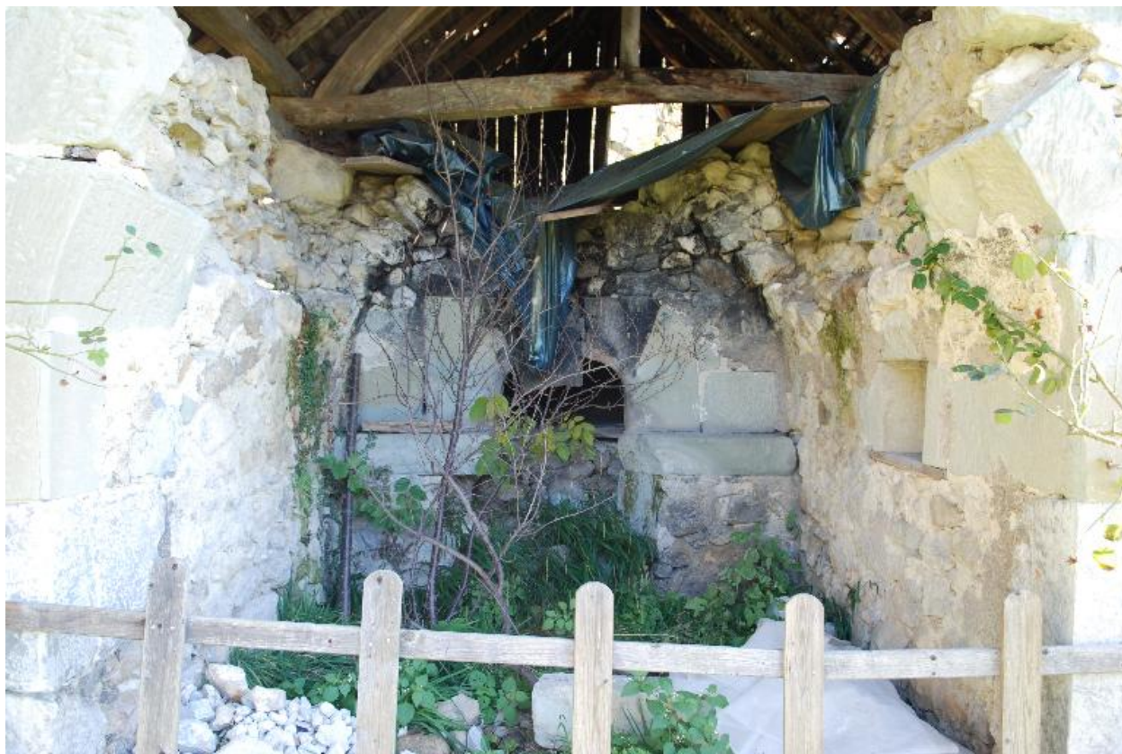
Vue d'ensemble intérieure du four à pain.
