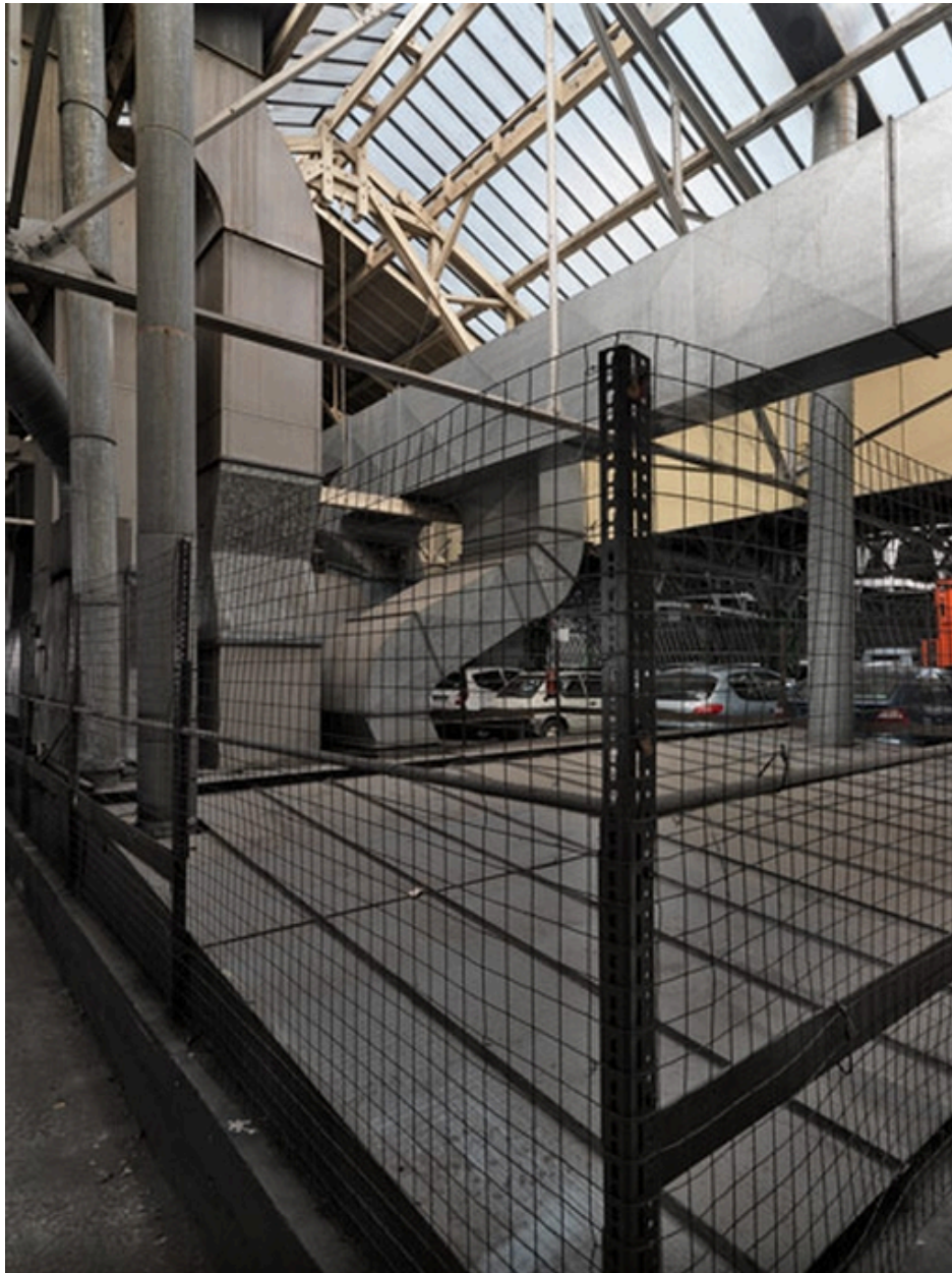
Barrière protégeant les verrières qui éclairent le 4e étage
