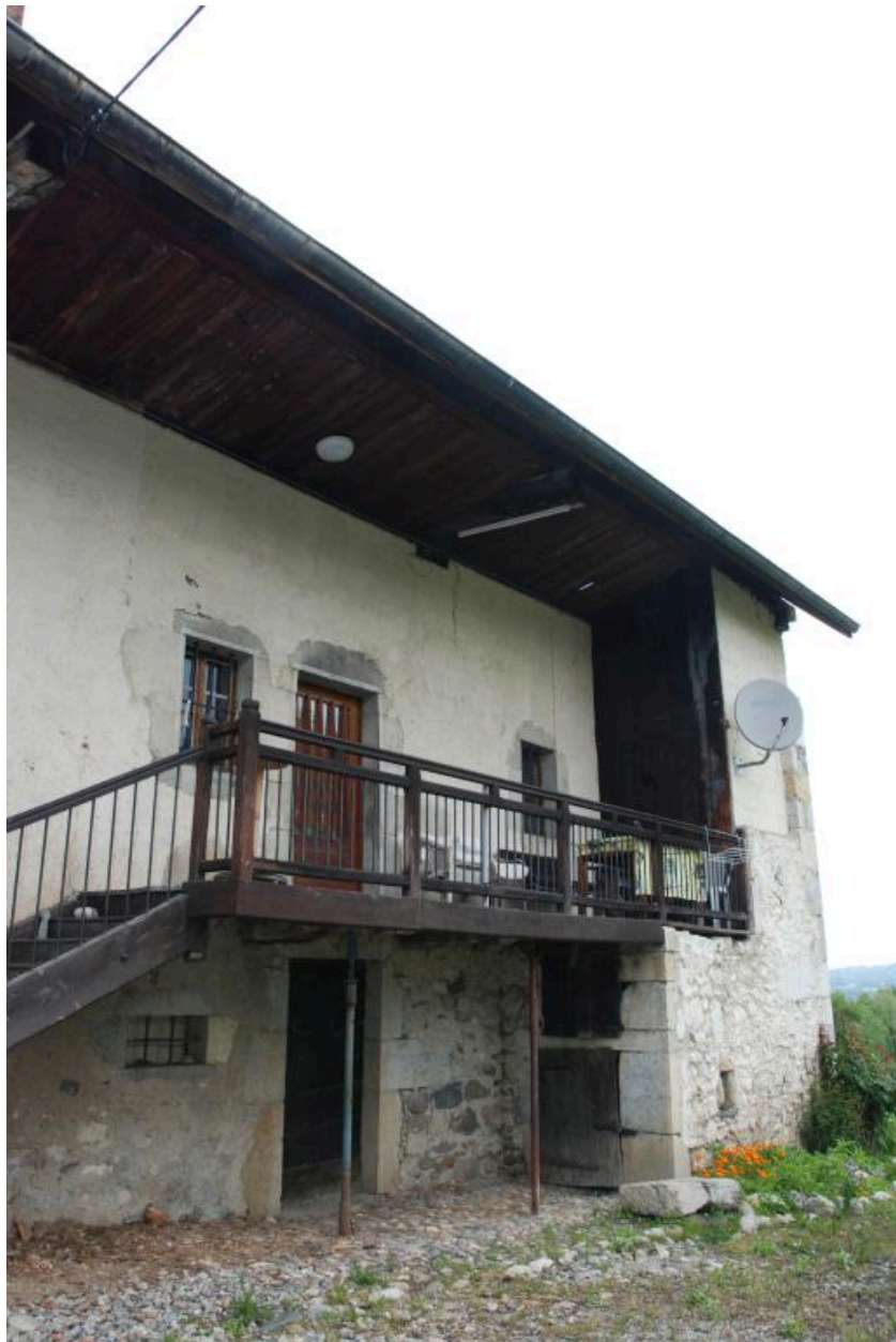
Détail de la façade antérieure : partie habitation.
