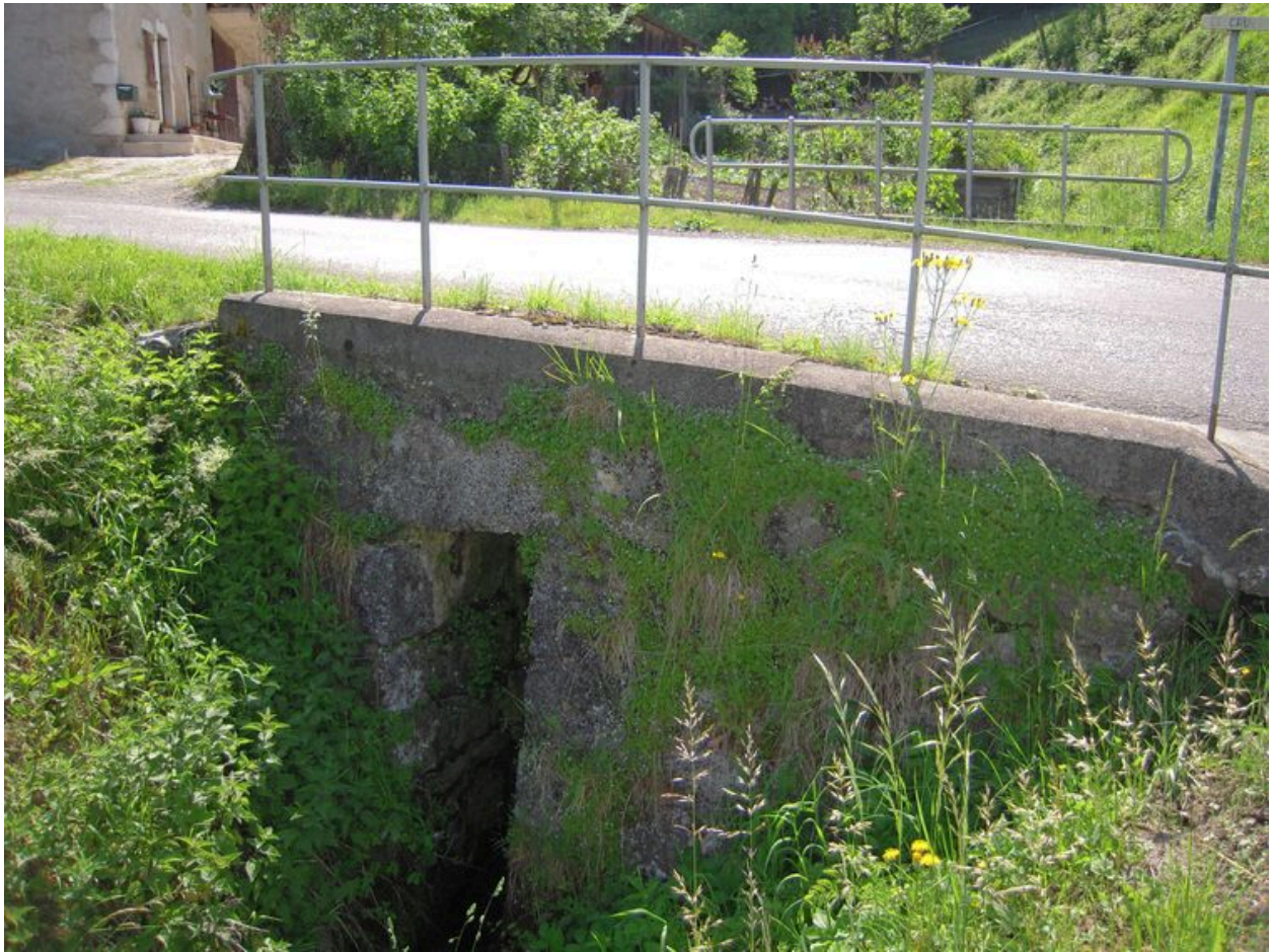
Pont au dessus du ruisseau du Cruet.
