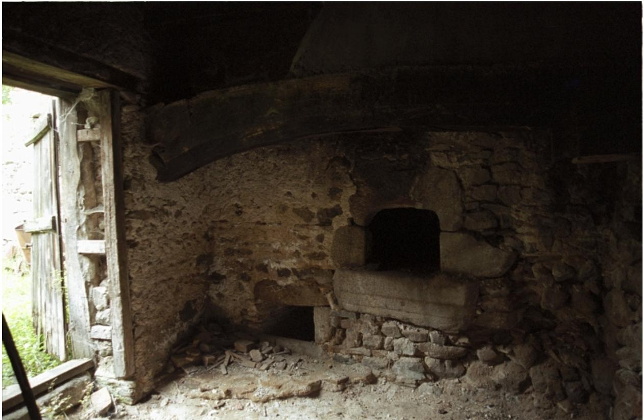
Vue d'ensemble intérieure du fournil avec la bouche du four à pain et, au sol, un cendrier pour y déposer les braises.
