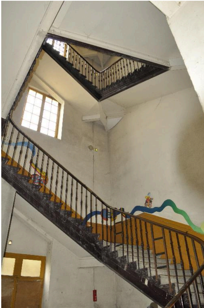
Bâtiment H. Aile Le Coeur Bellet. Escalier central, détail d'une révolution
