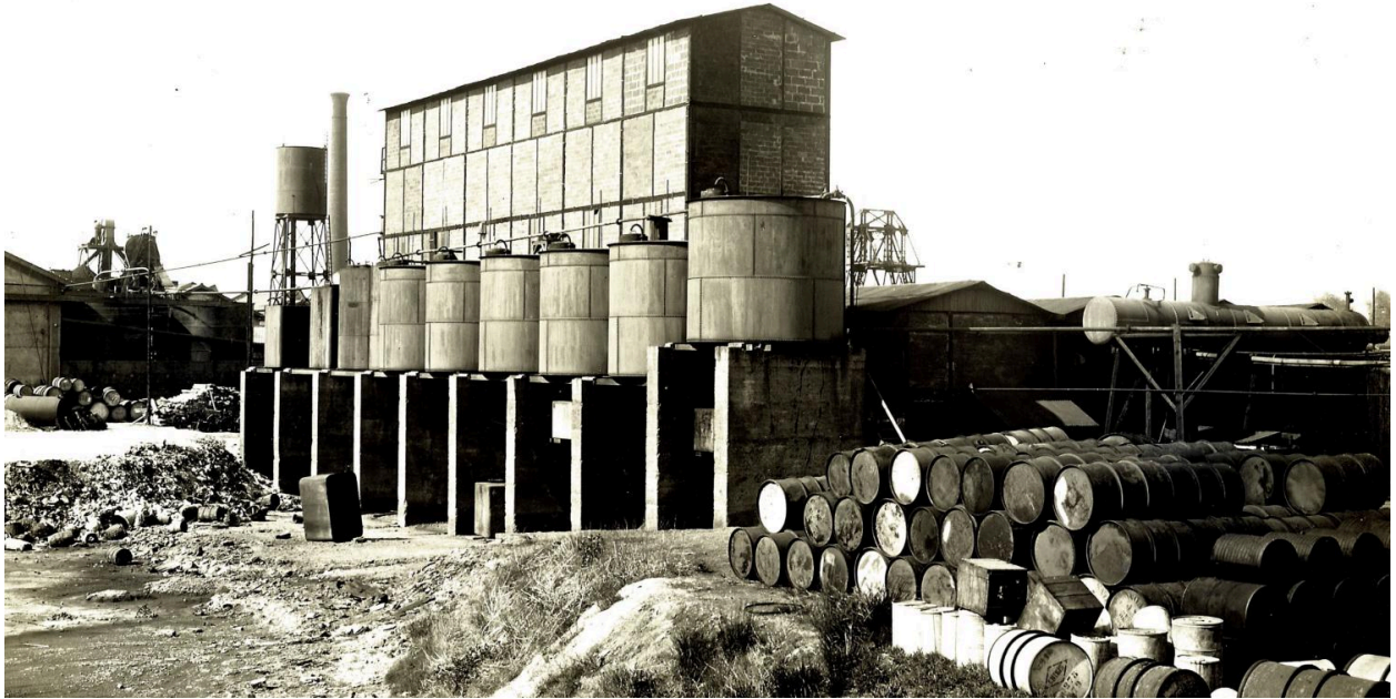
Vue extérieure de la Société chimique des usines du Rhône, 1923, Paris (8e) (AC Saint-Fons)
