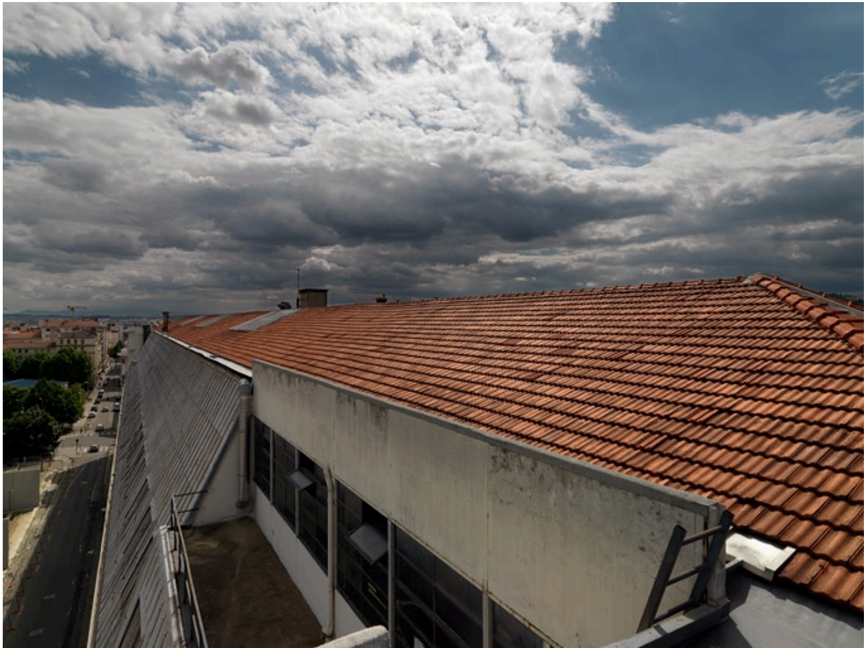
Vue nord du toit à longs pans
