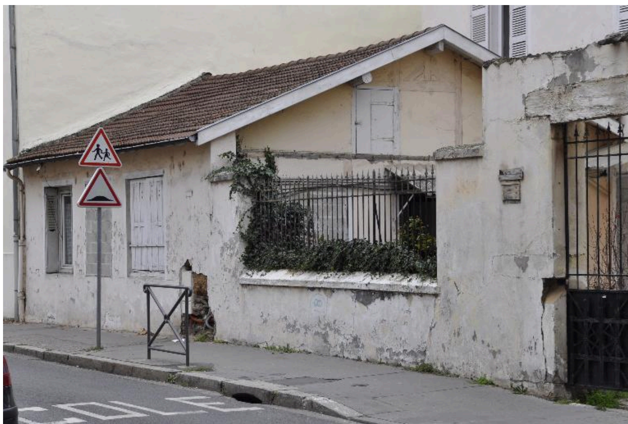
Vue de la remise
