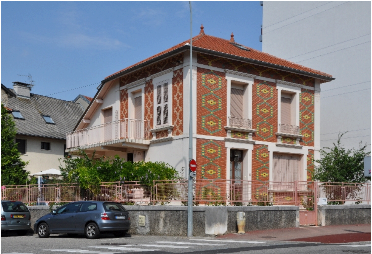
Vue depuis le sud-est
