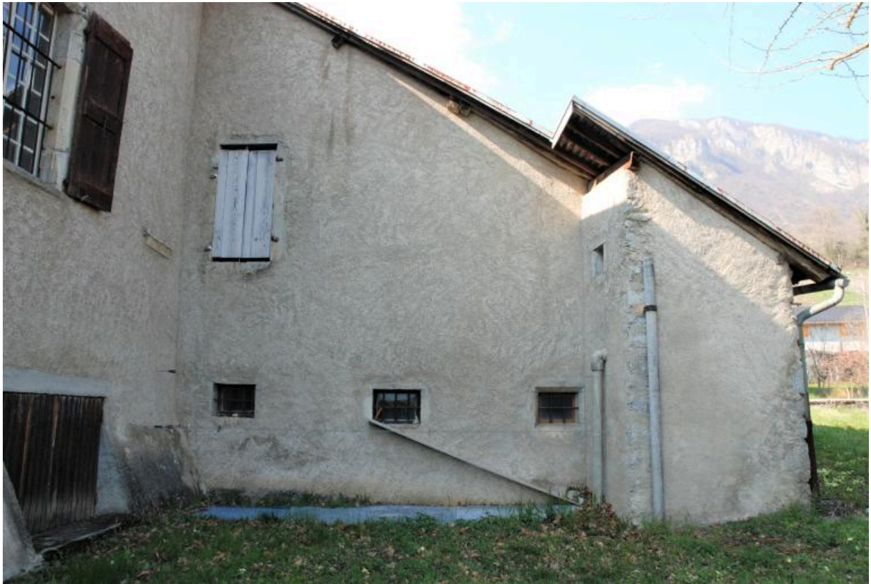
Façade sud du corps de bâtiment est.
