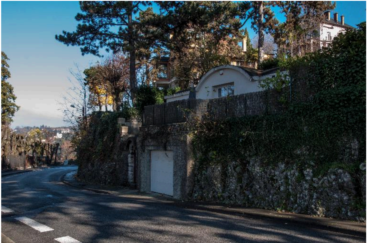
Ancienne loge de gardien sur le boulevard de la Roche-du-Roi
