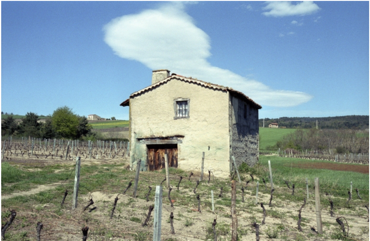
Pralong, La Croix de Places (1987 A1 639). Loge de type E1a2. Vue d'ensemble.
