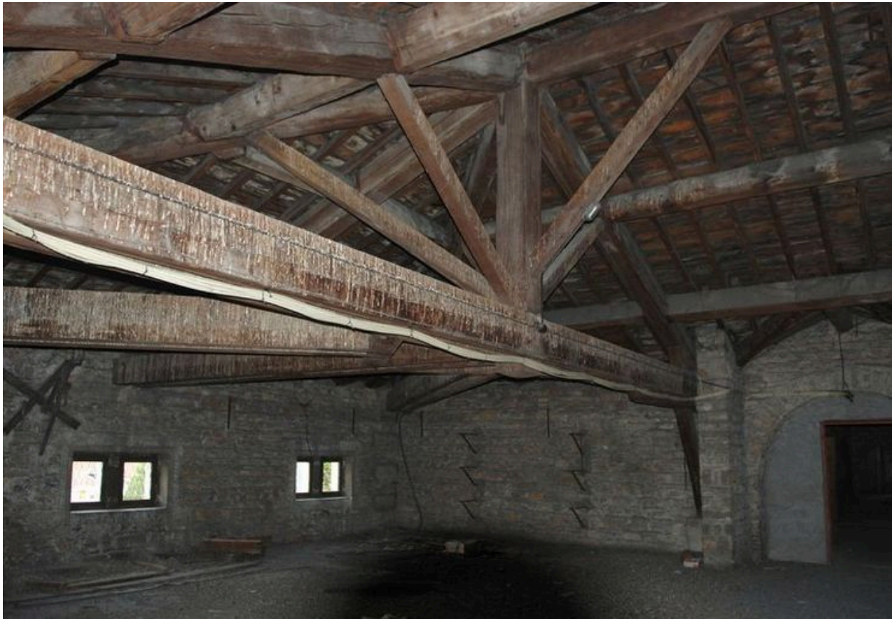
Bâtiment des services généraux, comble, détail de la charpente
