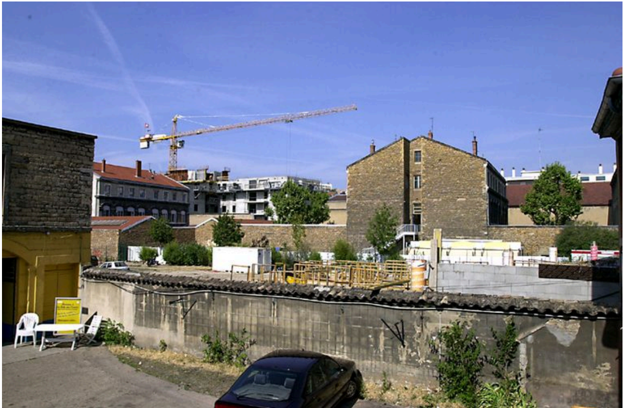
Vue de l'immeuble Le Bellini en construction depuis l'est
