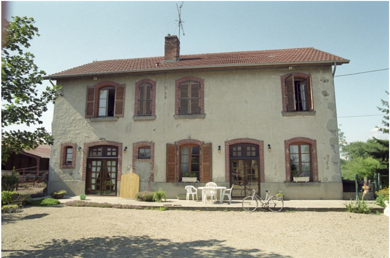
Vue d'ensemble du logis, façade antérieure.
