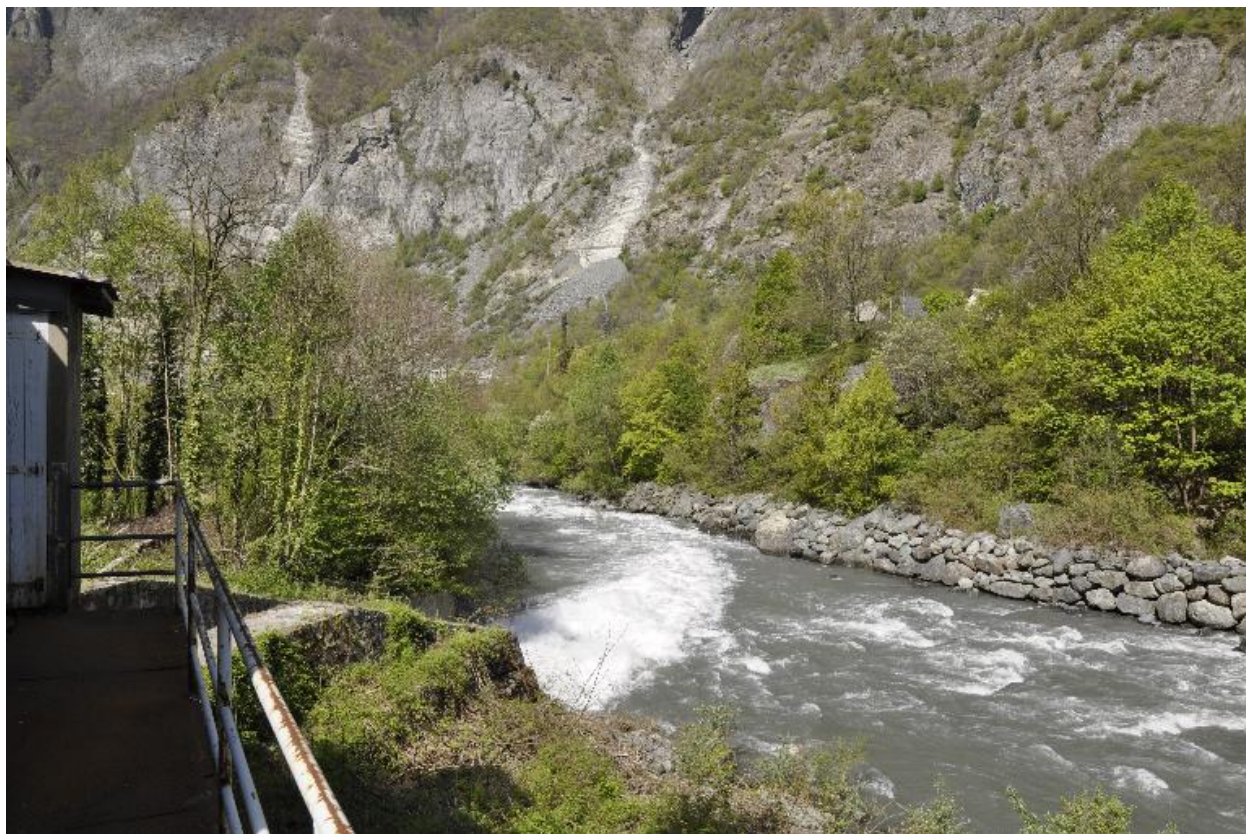
Vue du barrage de Rioupéroux
