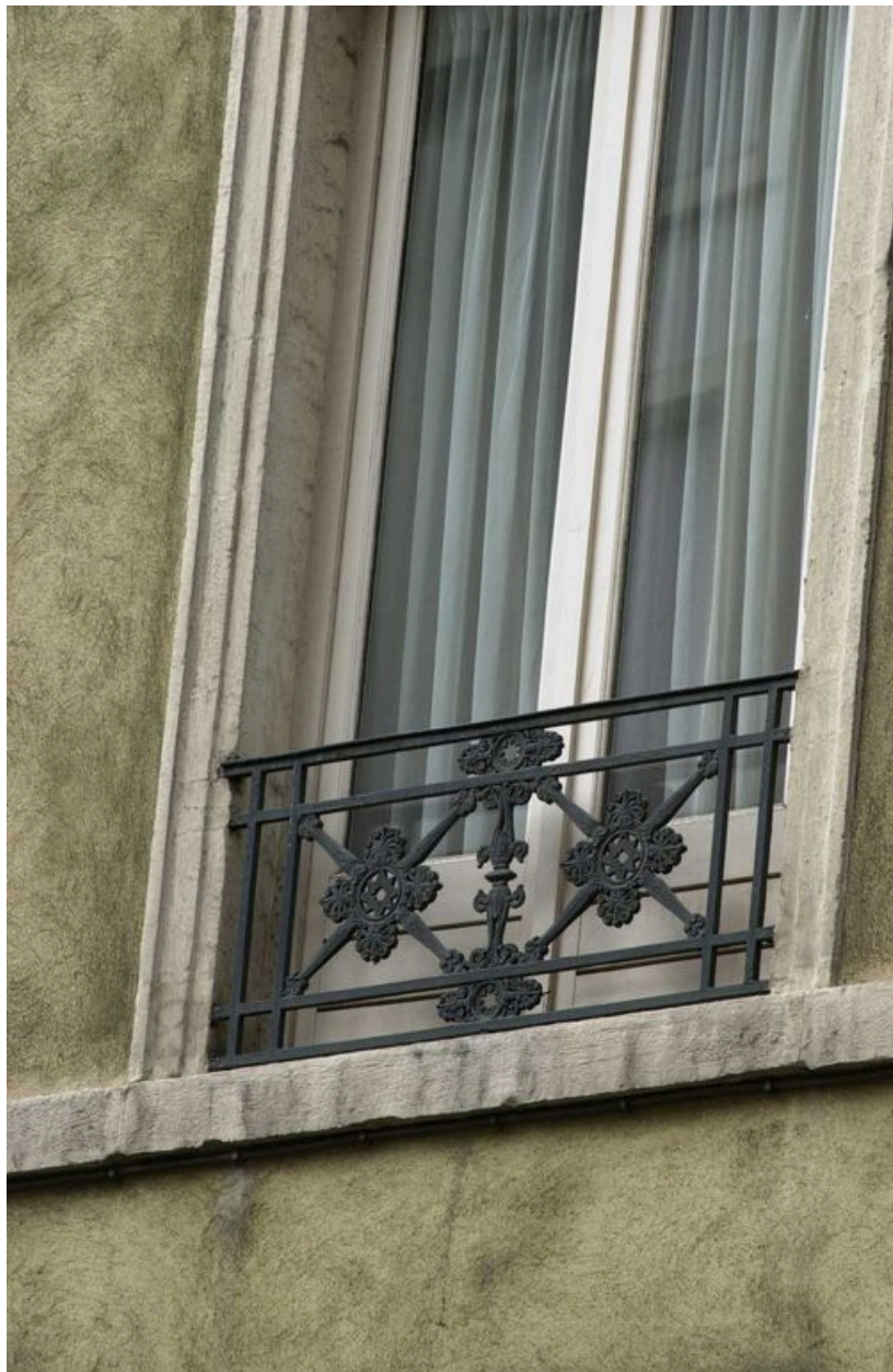
Détail d'un garde-corps, 2e étage Grande rue de la Guillotière
