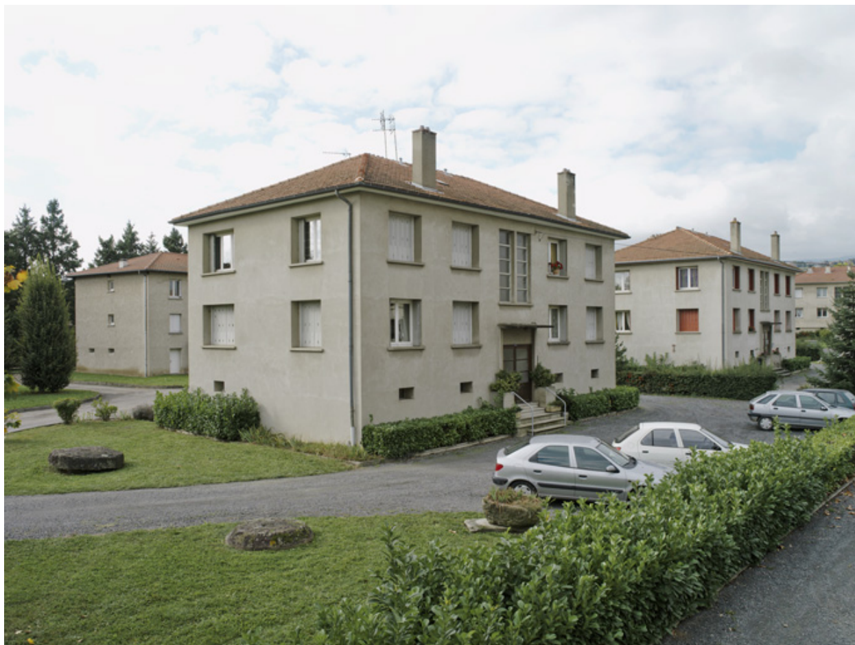
Vue en enfilade depuis le sud-est des bâtiments n° 3, 4.
