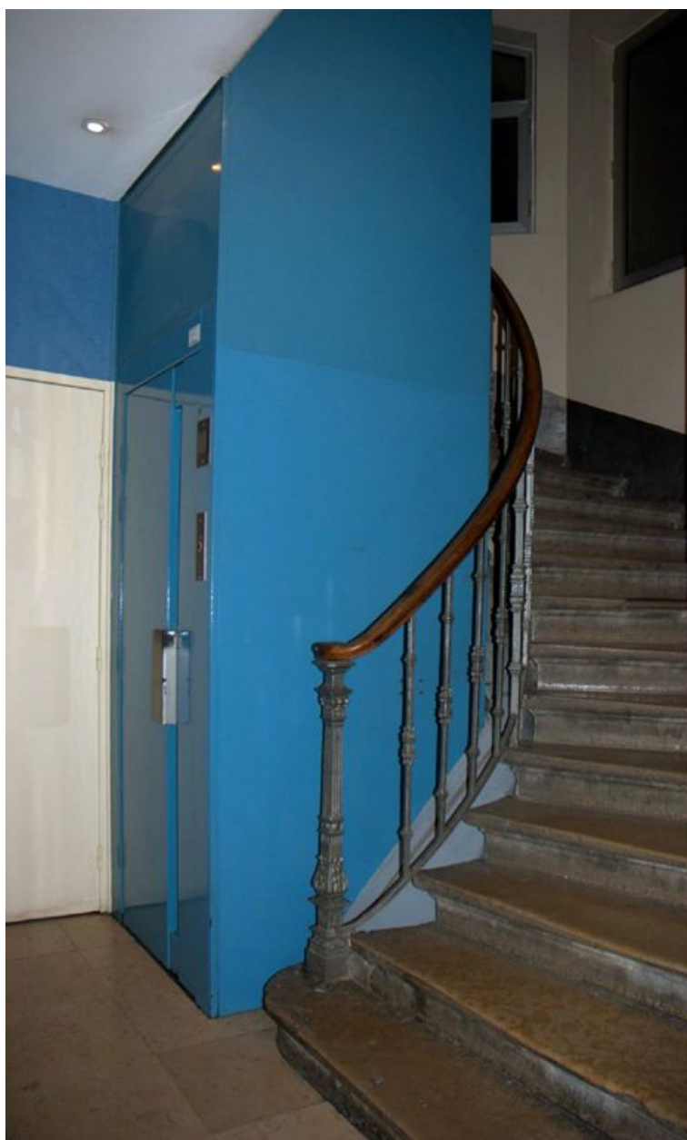
Première volée de l'escalier
