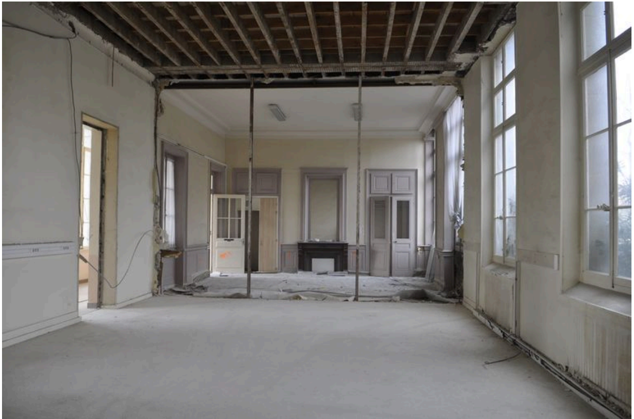
Vue du salon de l'école, en 2010, durant les travaux de transformation.
