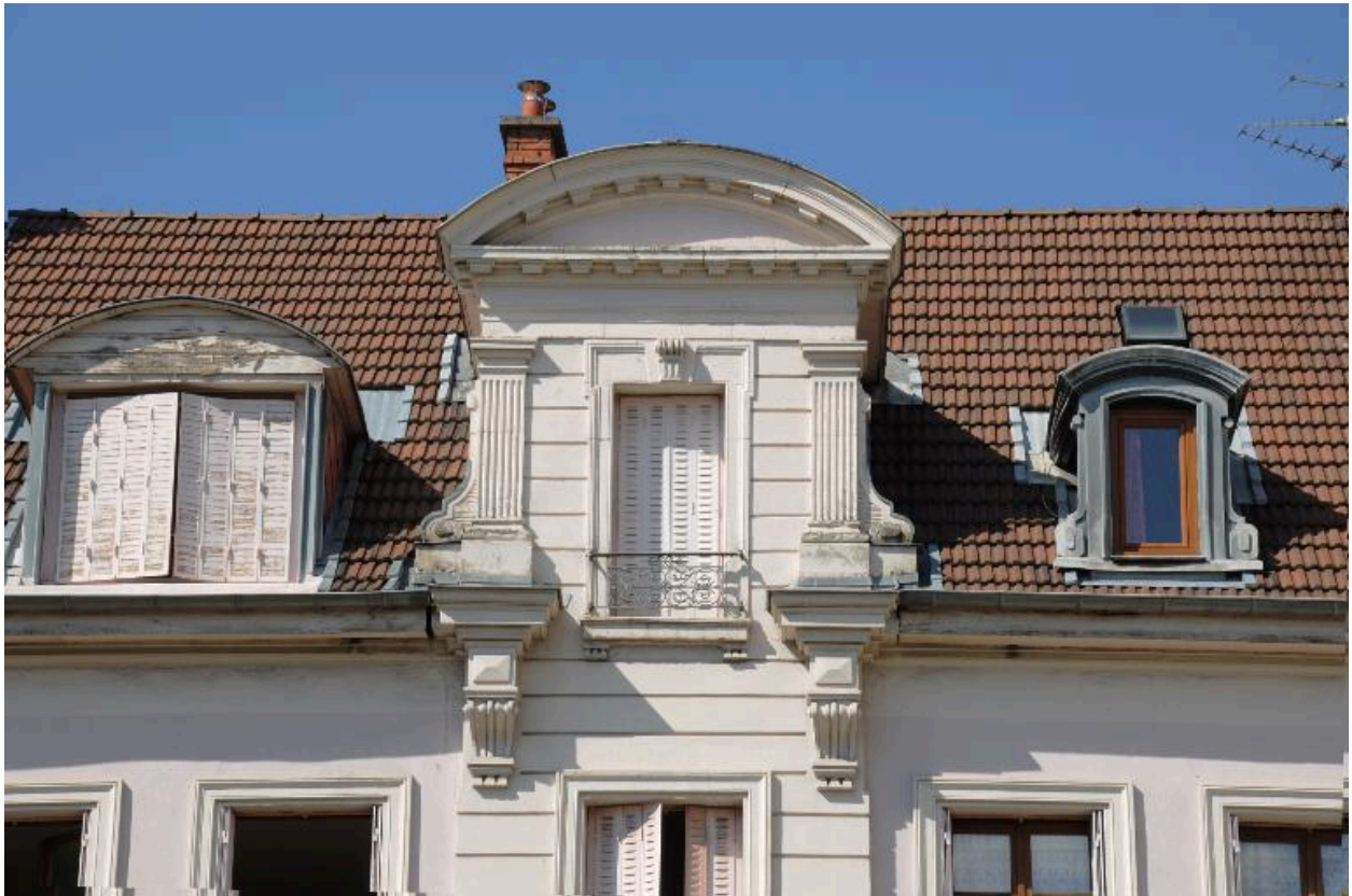
Lucarne-pignon à fronton cintré
