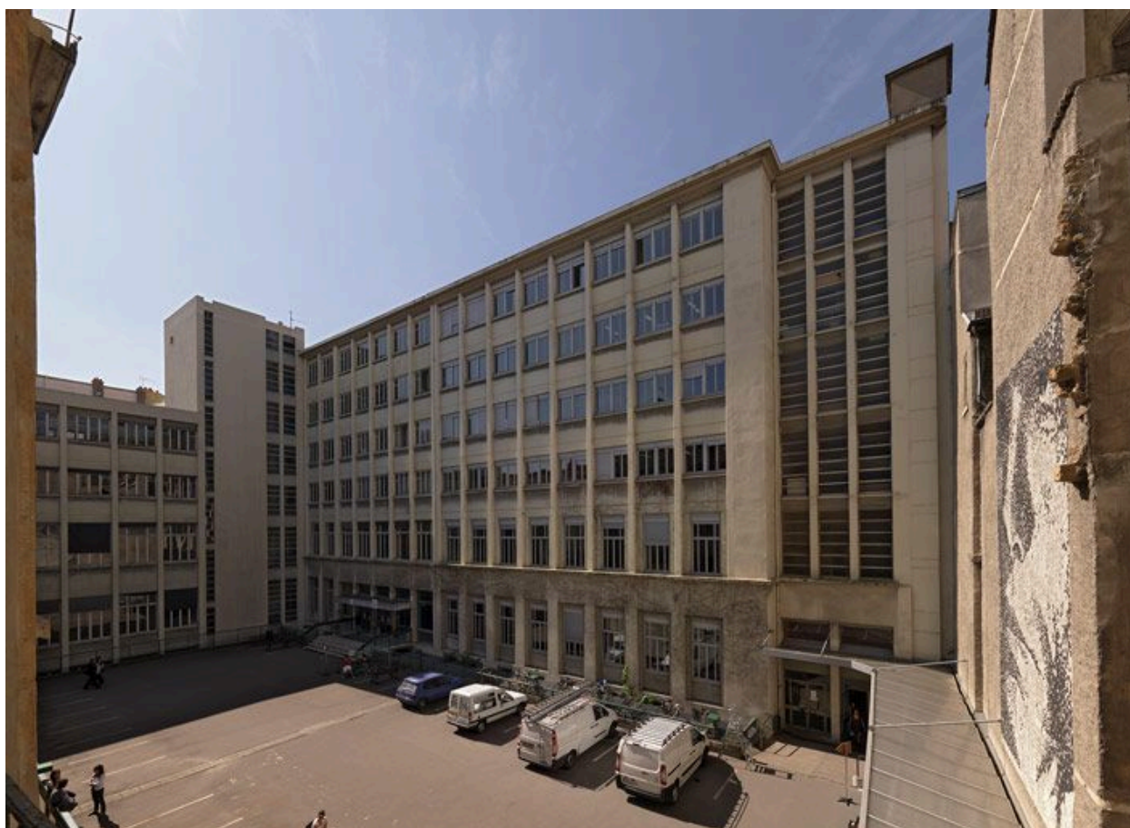
Belle Cour, vue d'ensemble depuis le nord-ouest
