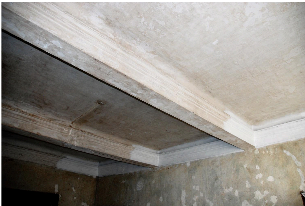
Maison, immeuble, 100 rue Louis Blanc-Pinget (2018 E1 1797). Vue intérieure du 1er étage. Détail de plafond.
