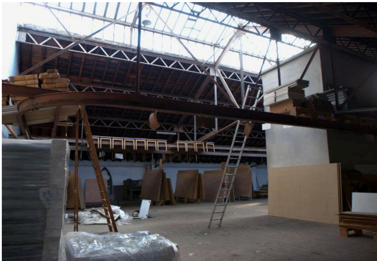
Atelier de menuiserie, charpente métallique
