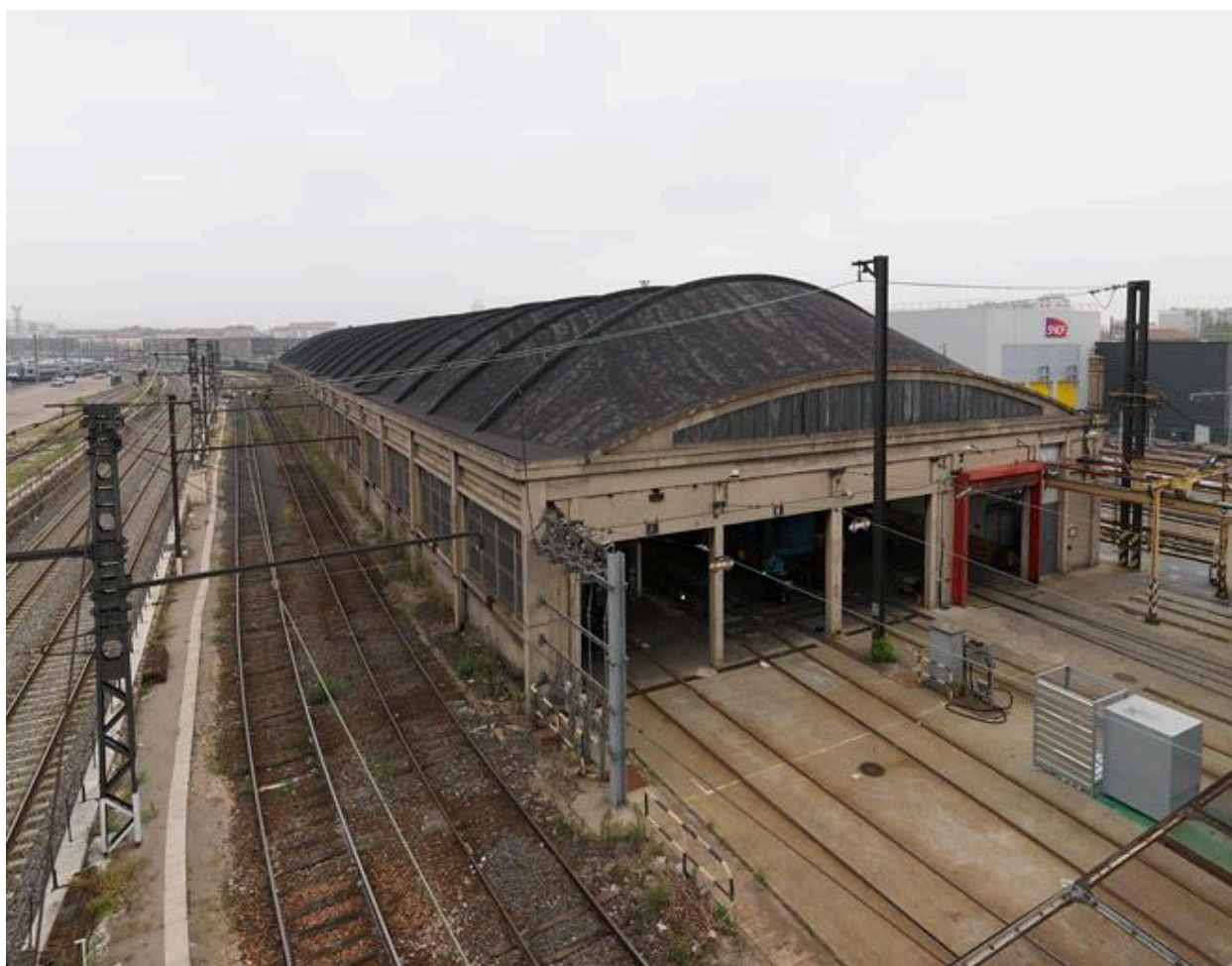
Vue d'ensemble sud de la halle
