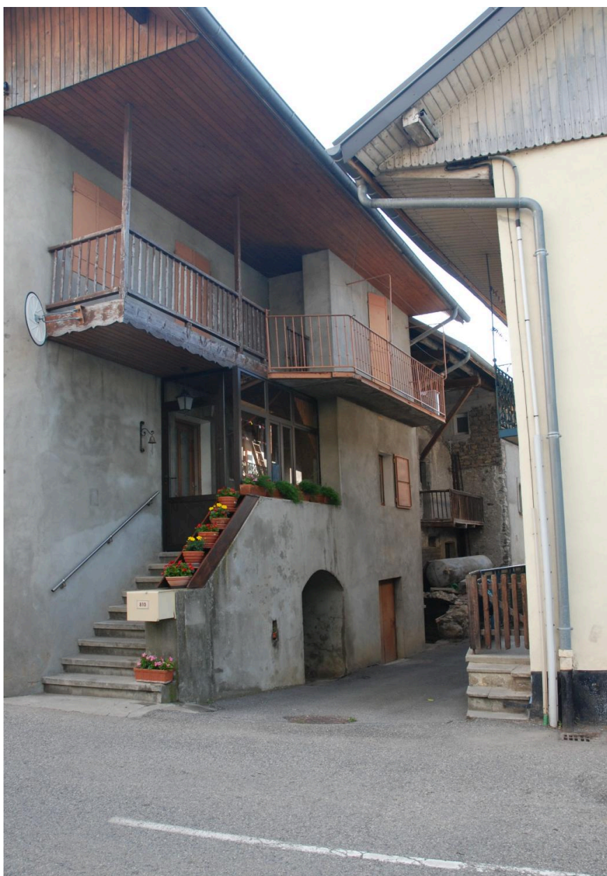
Maison de vigneron (2018 C2 407).
