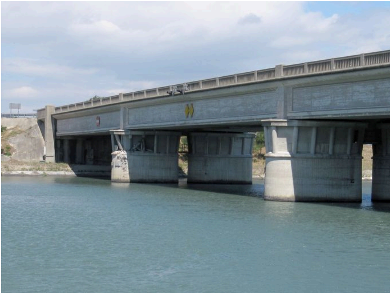
Vue partielle, travées senestres, face amont (depuis la rive droite)
