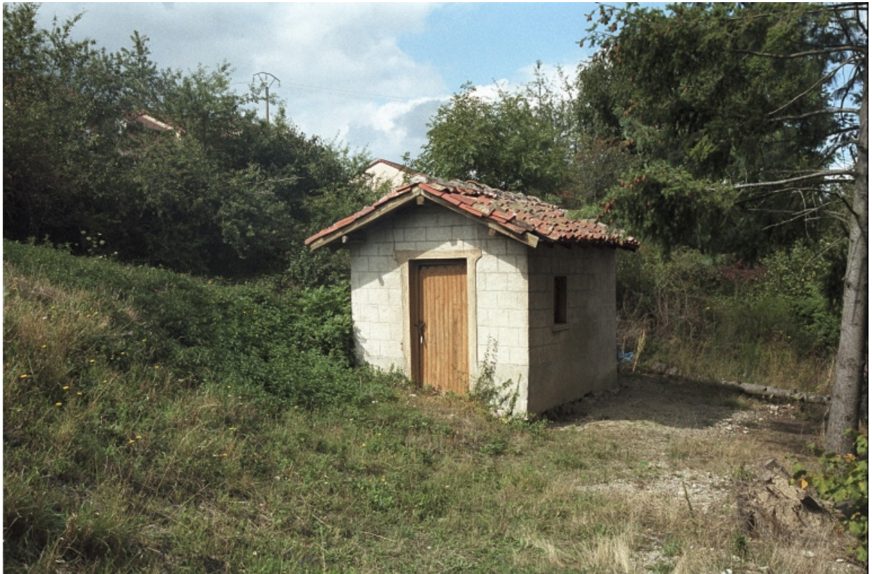
Boën, Guêt-Nord (1986 AC 91). Loge en rez-de-chaussée de type R1a1. Vue d'ensemble.
