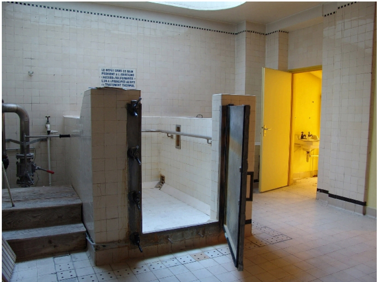
Ancien berthollet en sous-sol
