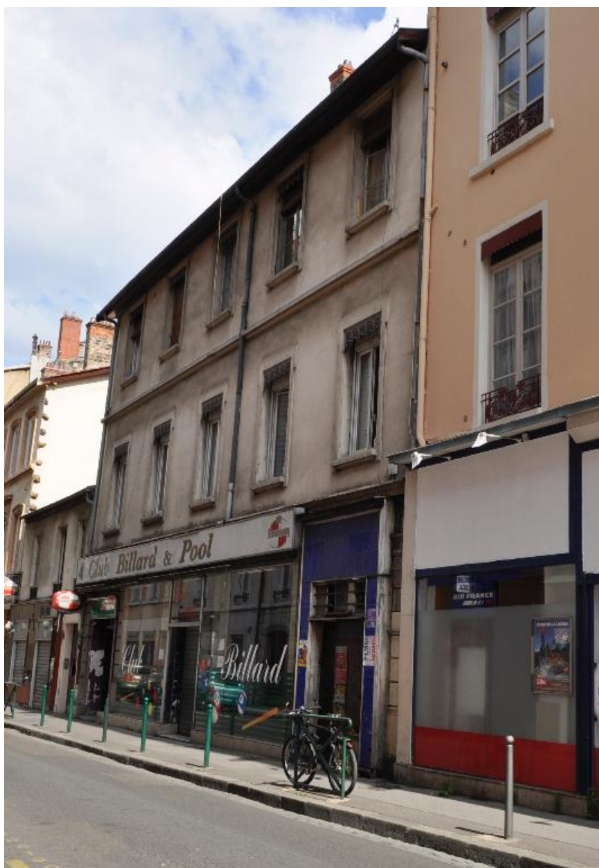
Vue générale de l'élévation sur rue
