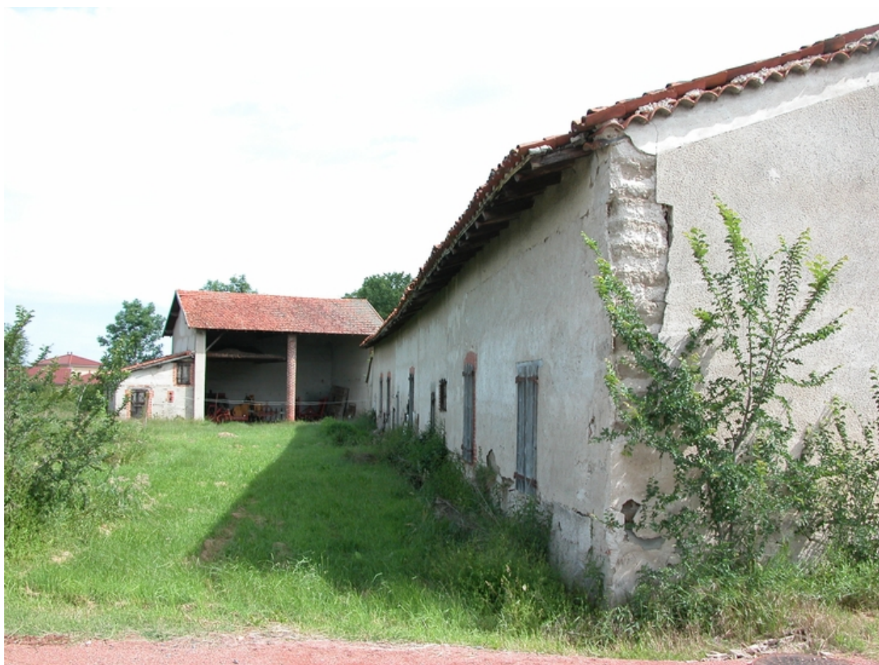
Vue arrière du bâtiment ouest, depuis le sud.
