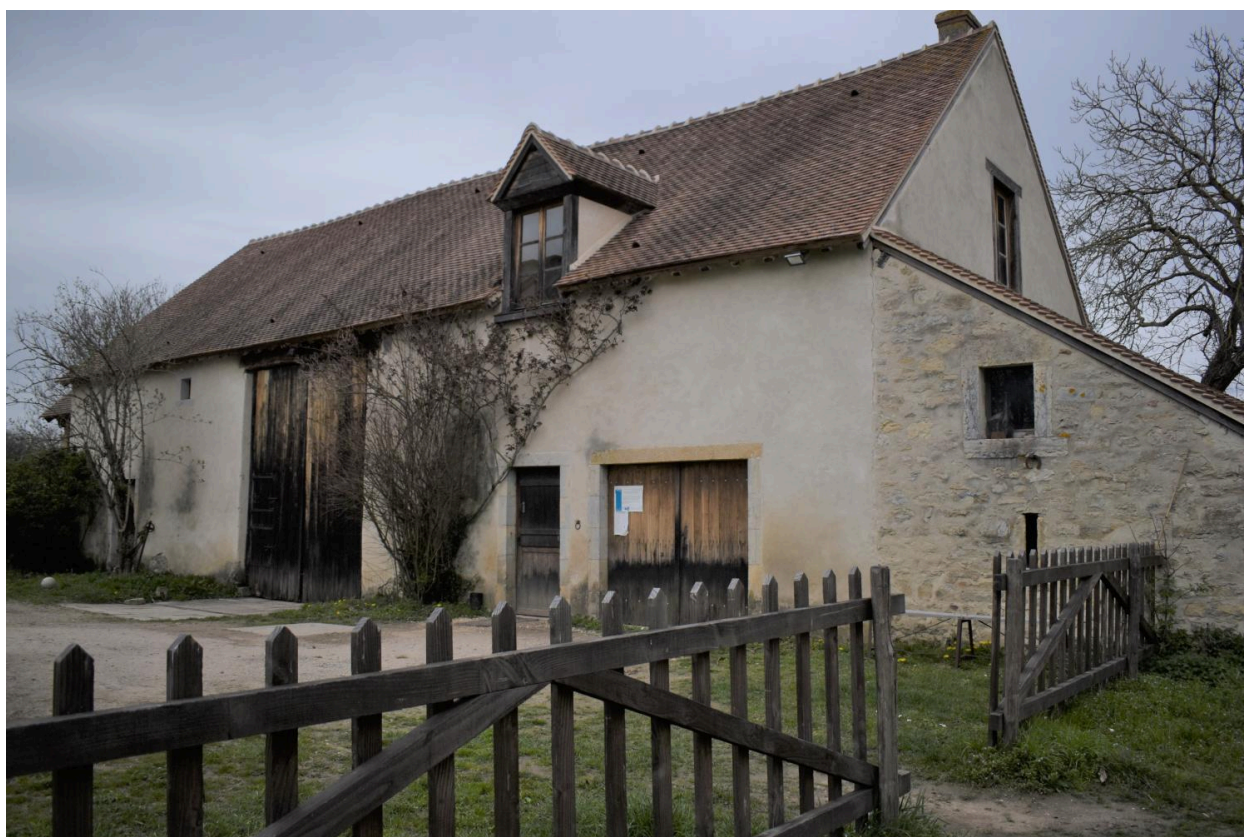
Vue générale de la grange.
