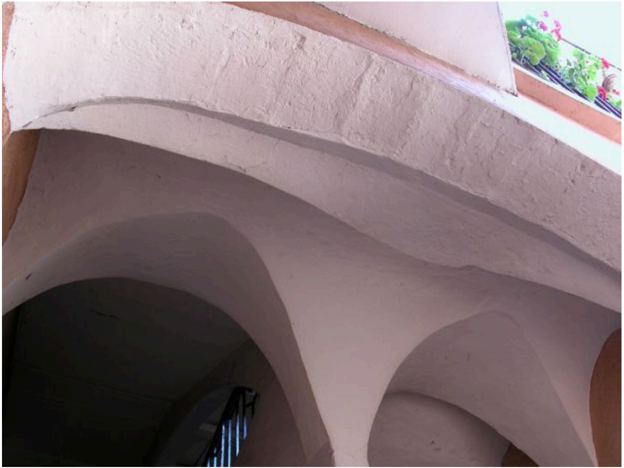
Escalier, voûte d'un repos
