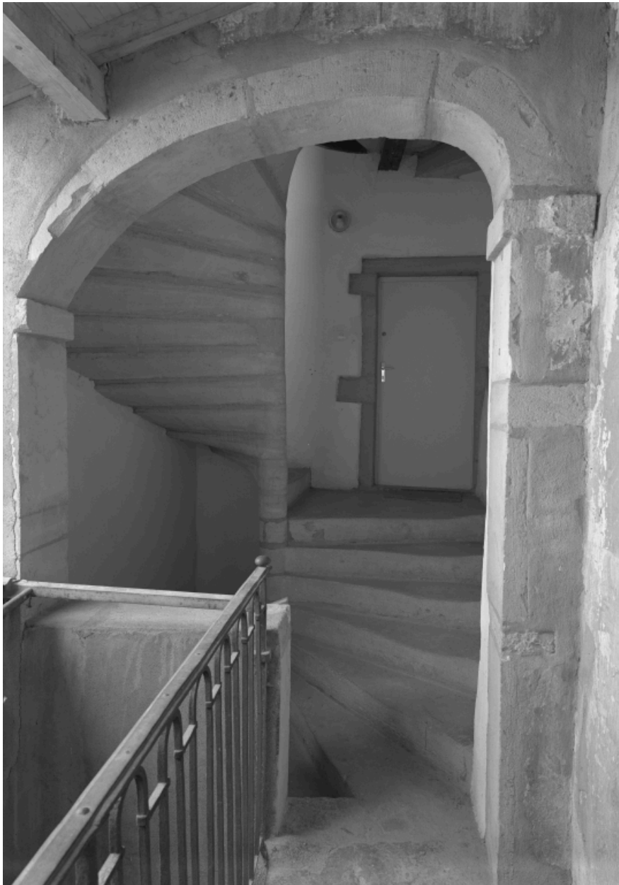
Cage d'escalier du 39 Grande rue, au niveau d'un demi-étage.
