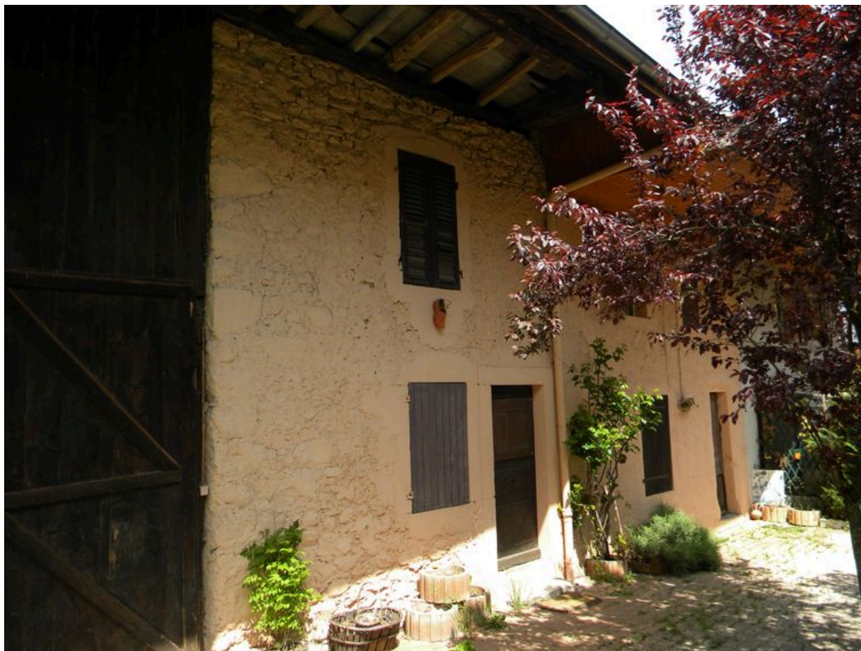
Vue globale de la façade principale.
