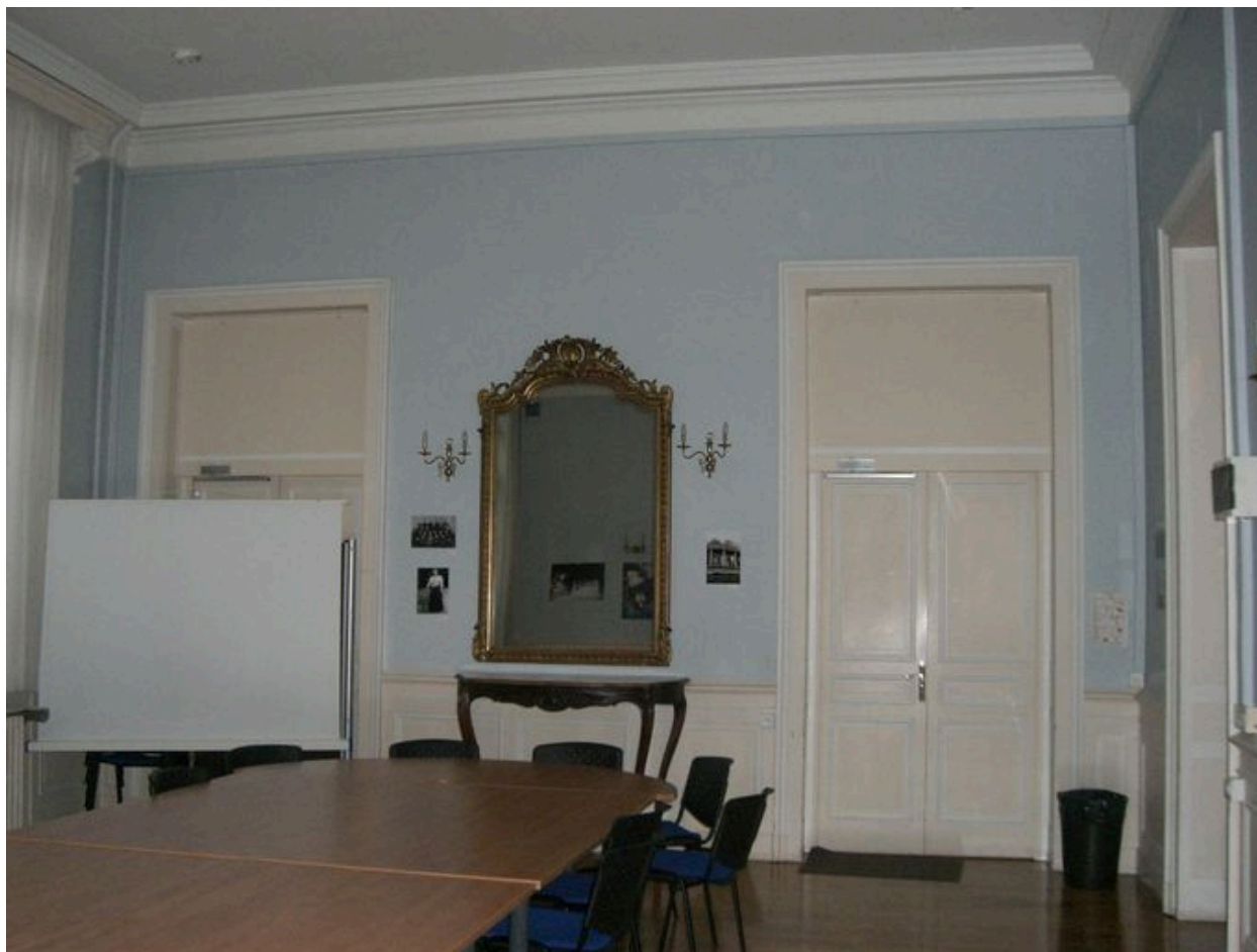
Vue de l'ancien parloir-salon en 2009, avant les travaux de transformation.
