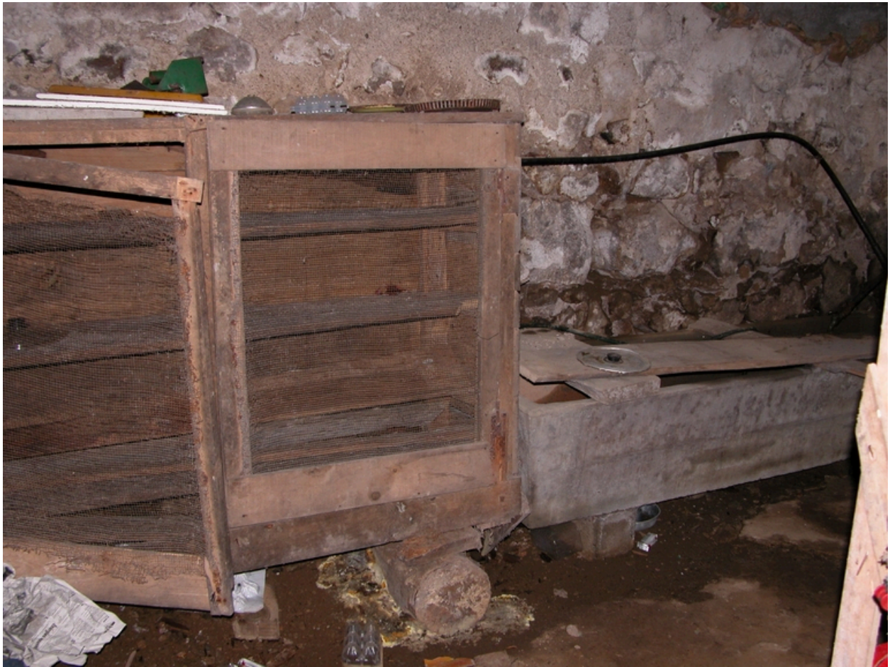
Vue intérieure de la cave.
