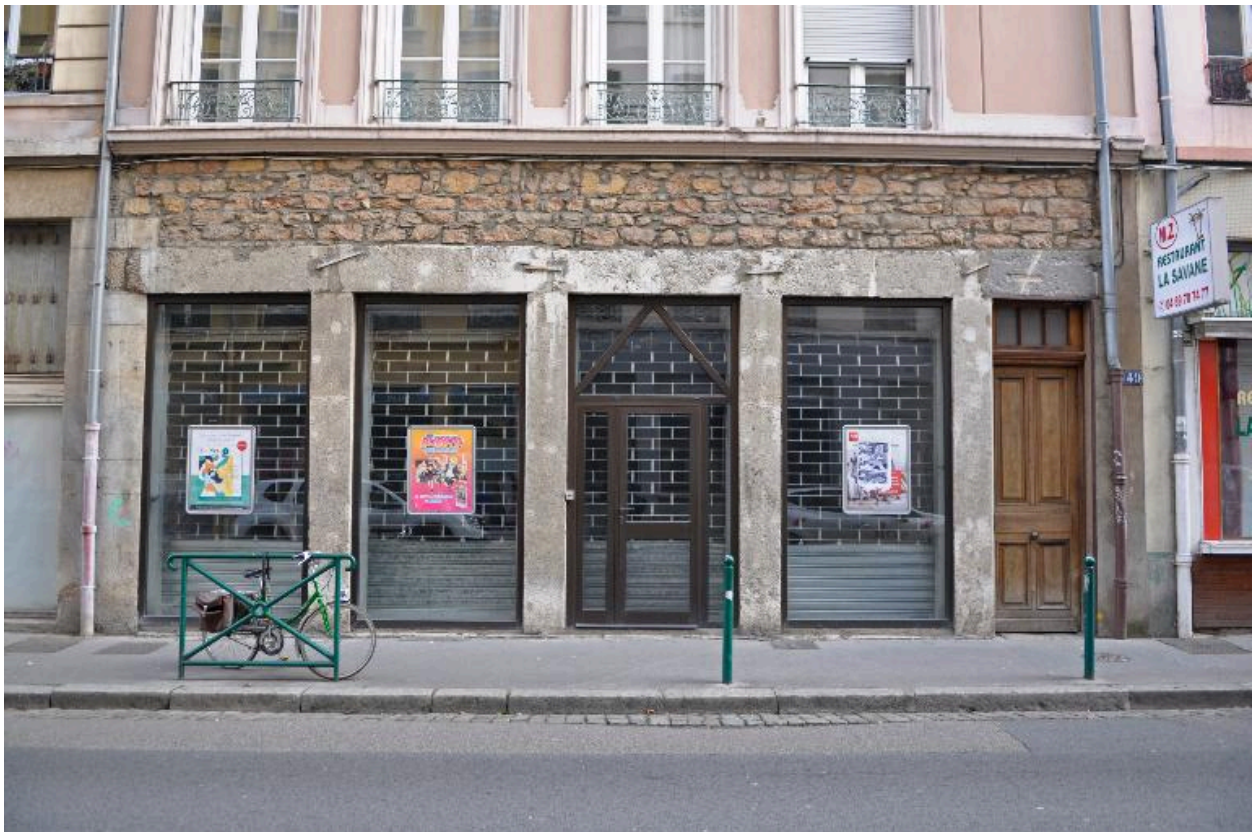
Élévation sur rue, détail du rez-de-chaussée montrant l'association des matériaux
