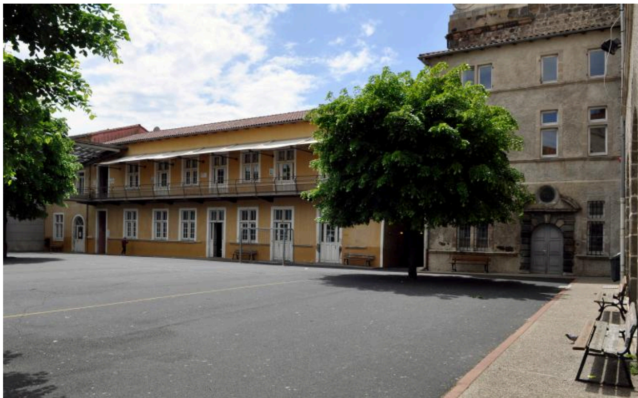
Bâtiment C : élévation sur cour 2, depuis le nord-est
