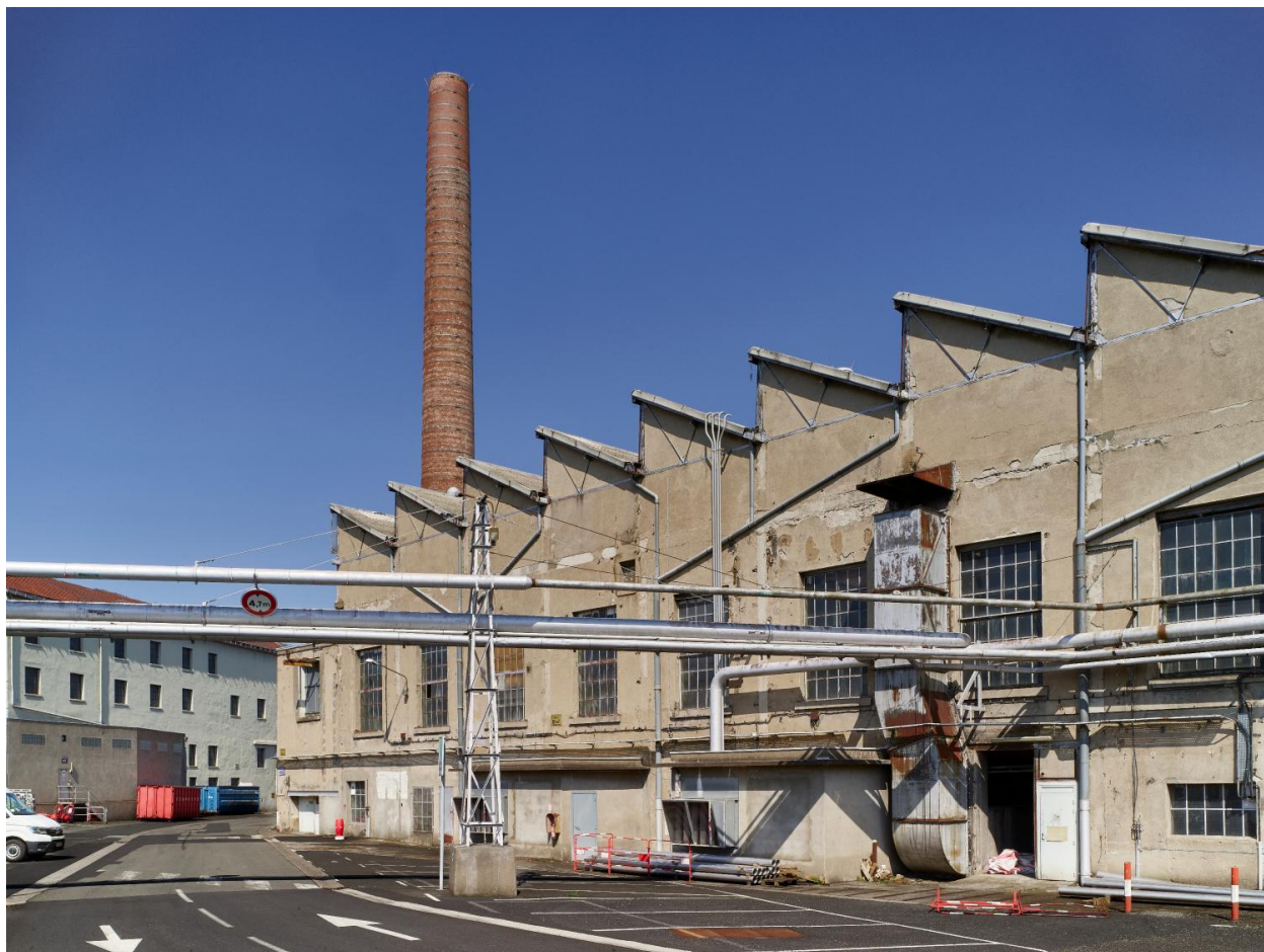
Élévation ouest du bâtiment B41 de la chaufferie ; à l'arrière plan, l'une des cheminées encore en place.
