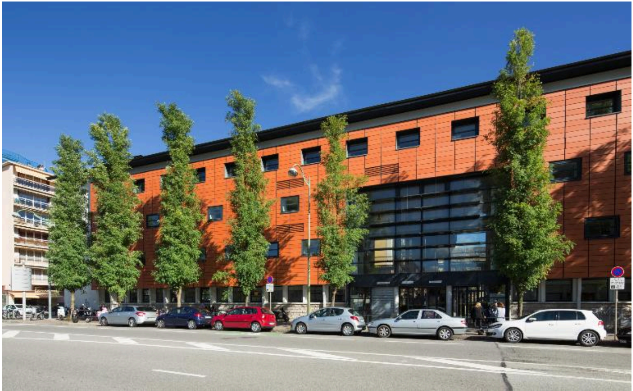
Façade sur avenue de Brogny.
