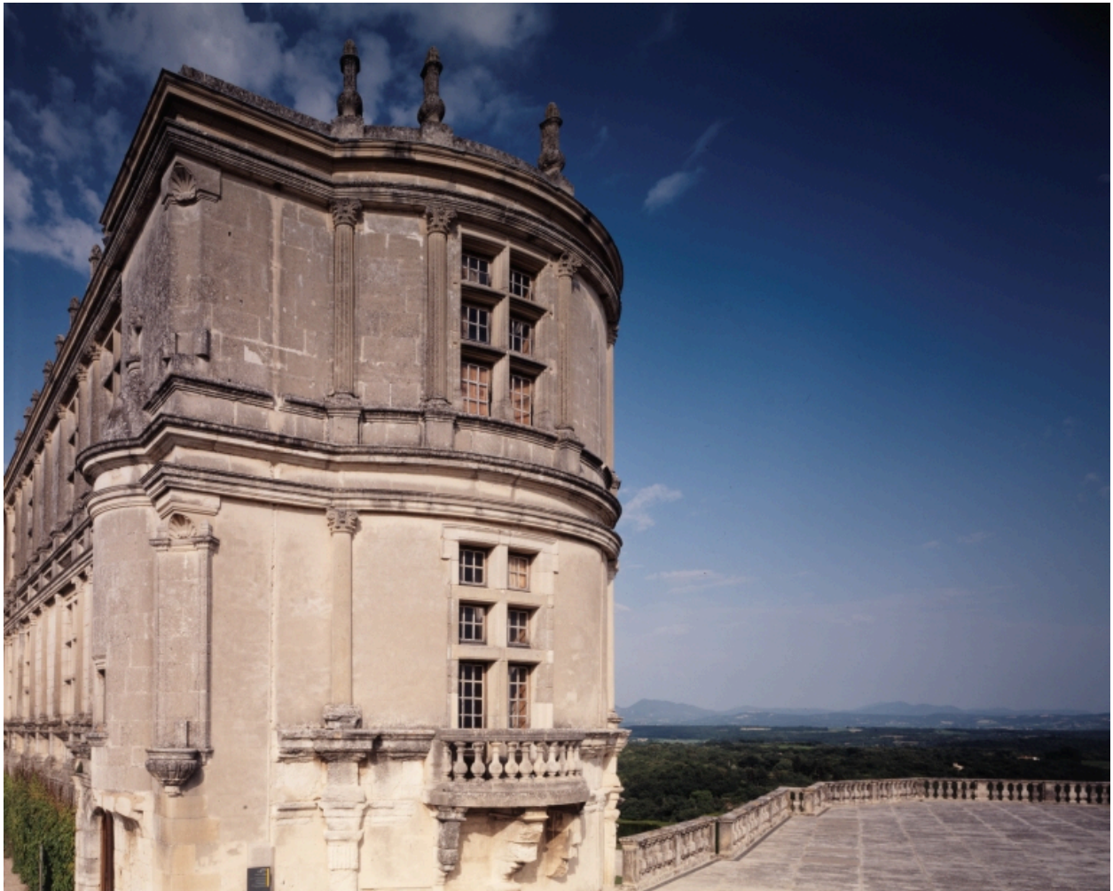
Bâtiment sud. Tour sud-ouest. Vue générale prise depuis la terrasse.
